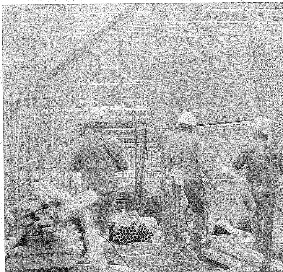
Operai impegnati in un cantiere edile
